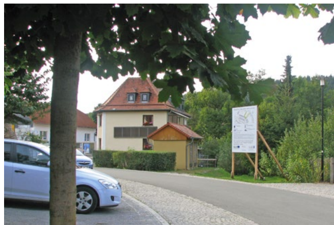
An das Ortsbild angepasste Trafostation in Tannroda, 2013
