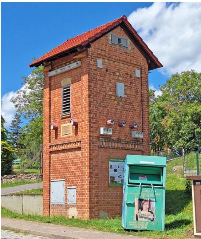
Artenschutzturm in Röhrensee (Amt Wachsenburg), Baujahr 1925, Umbau 2014, 2024
