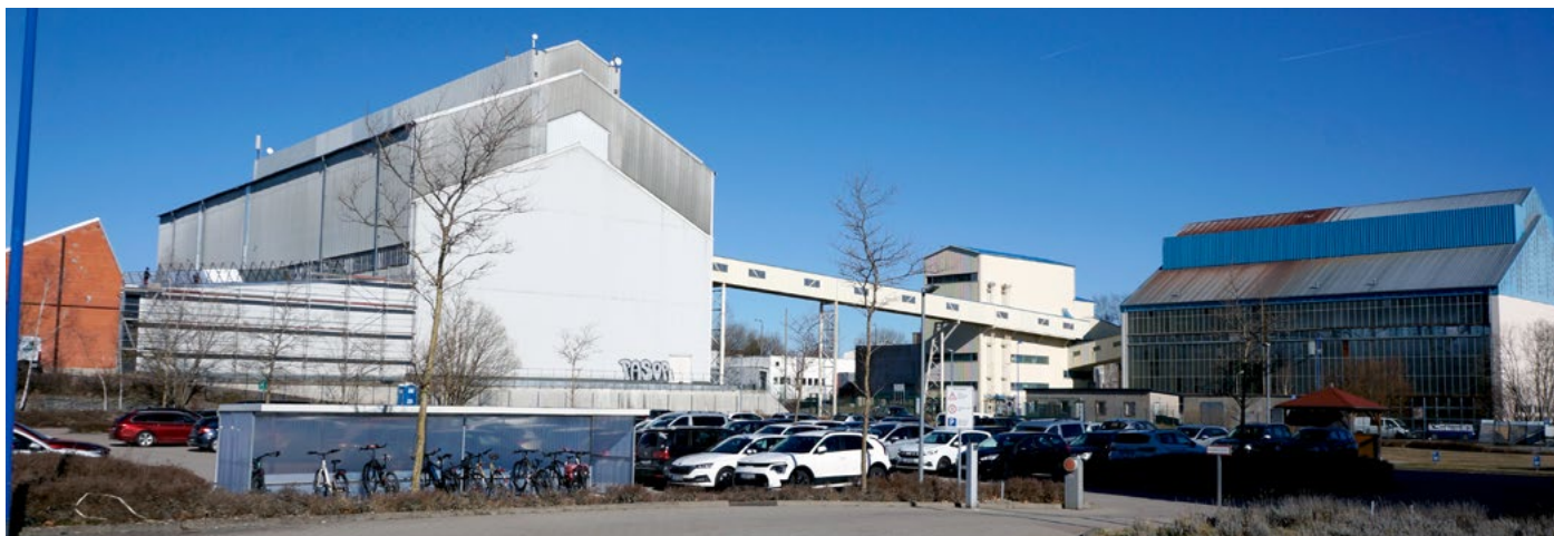
Blick auf die Schmelzwannenhallen des ehemaligen VEB Technisches Glas Ilmenau, 2025
