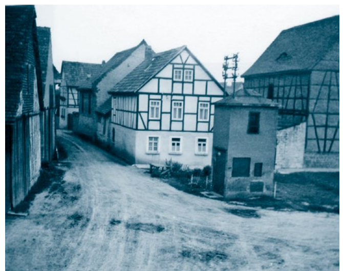
Alte Trafostation in Mellingen, um 1935 (Foto: Gerhard Mordt, Mellingen, [7])
