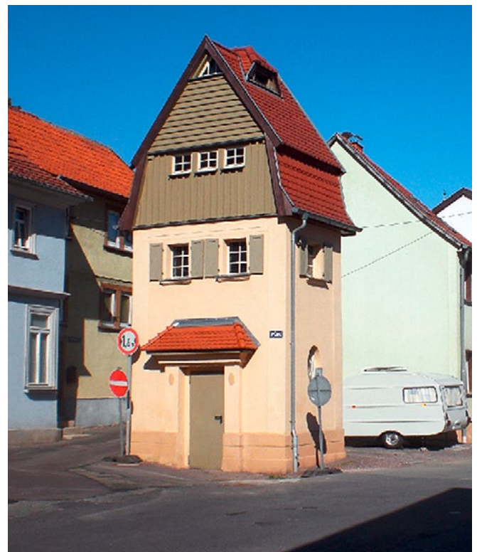
ehem. 6-kV-Ortsnetzstation „Am Plan“ Waltershausen, Inbetriebnahme um 1920, 2008 Sanierung (Foto: W. Schossig, 2014)
