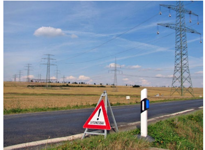
Trassenbündelung von Hoch- und Höchstspannungsleitungen zwischen Schellroda und Klettbach, 2013
