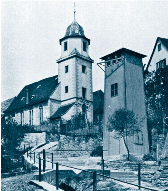
„Ein dörfliches Idyll wird durch einen Blechturm gefühllos erschlagen“ (Foto [6])
