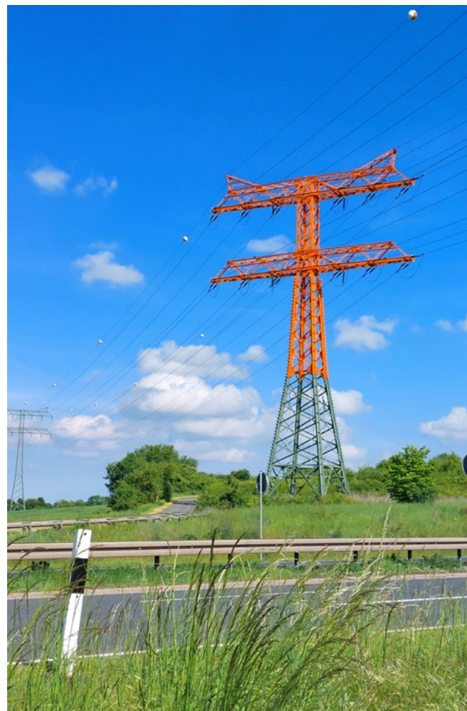
110-kV-Mast mit roter Warnfarbe an der Ostumfahrung des „Erfurter Ringes“, 2025
