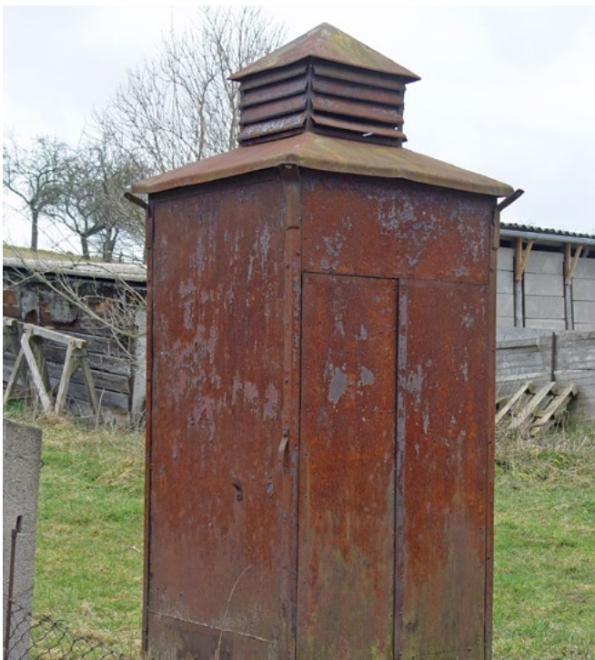
Diese ehem. 3-kV-Station aus Blech war jahrelang in Erfurt im Einsatz. Heute ist sie Ausstellungsstück des Elektro-Museums Erfurt (Foto: S. Hloucal, 2014)
