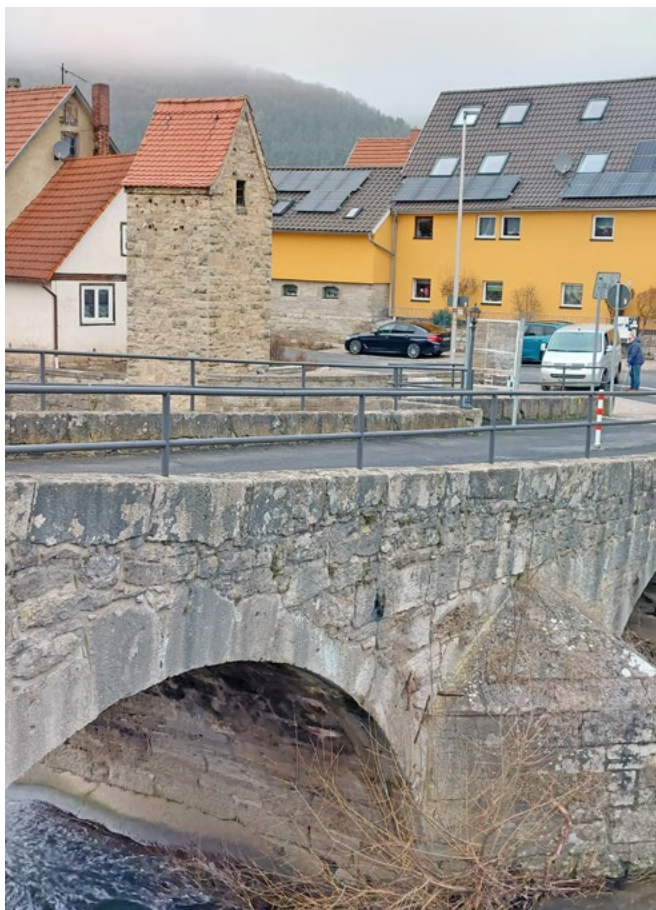
alte Trafostation in Obermaßfeld, 2024
