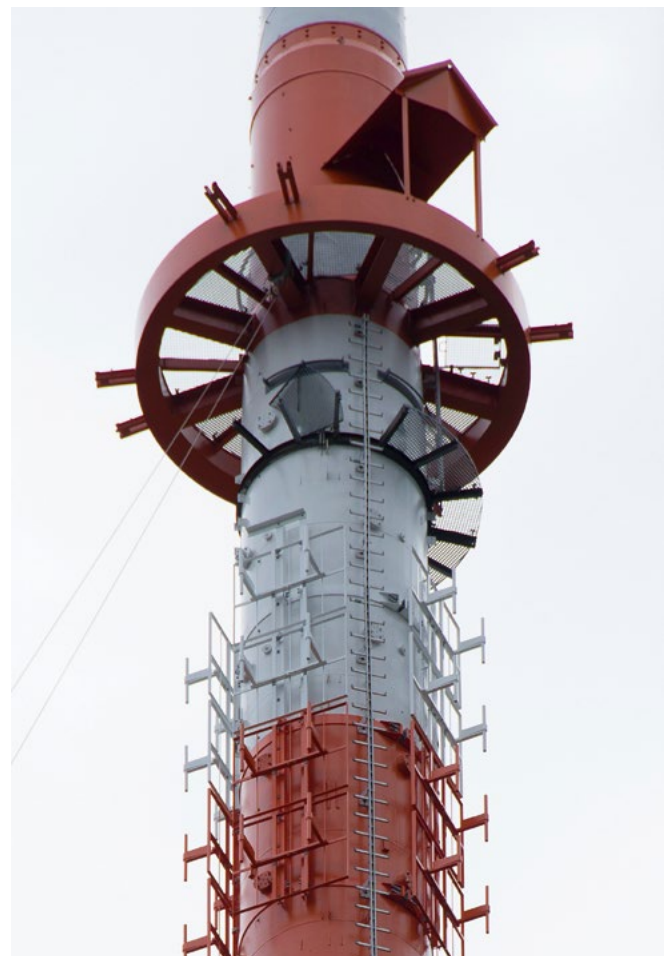
Dipolgruppe für DAB+ am Antennenturm auf dem Großen Inselsberg, Kanäle 5C und 8B
