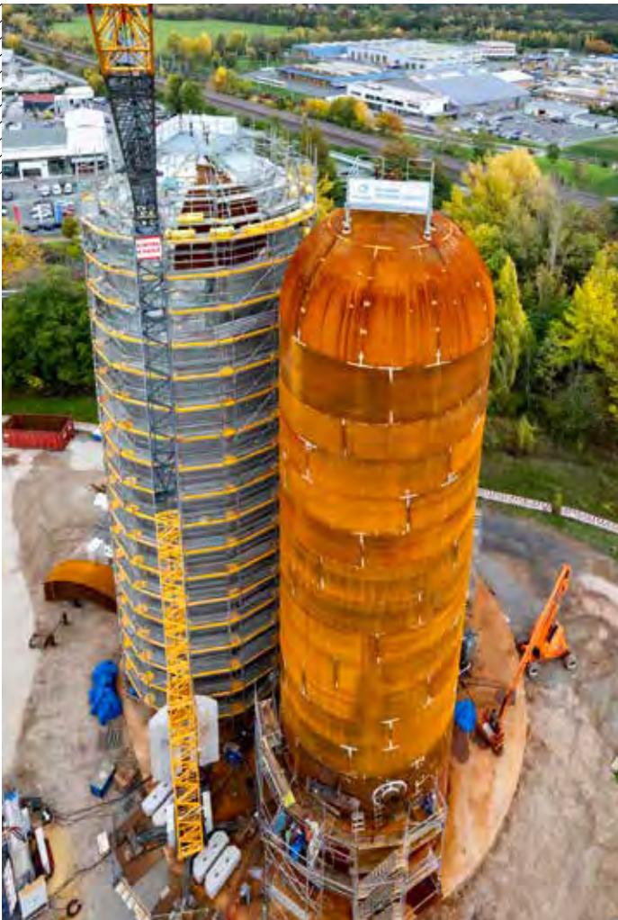
Die drei stählernen Heißwasserspeicher wurden exakt auf dem alten Fundament des früheren Kohleschornsteins errichtet.
