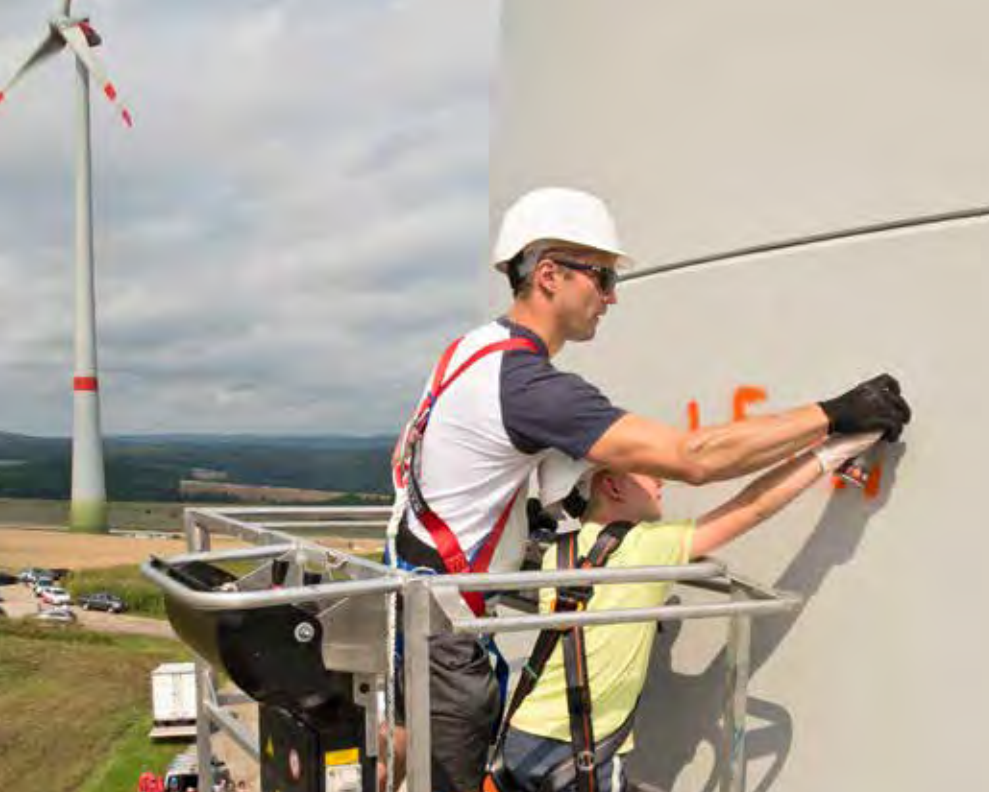
Auch zum dritten Tag der offenen Tür kommen wieder viele tausend Gäste. Dabei können diesmal u. a. Windkraftanlagen mit dem Hubsteiger erkundet und „beschriftet“ werden.
