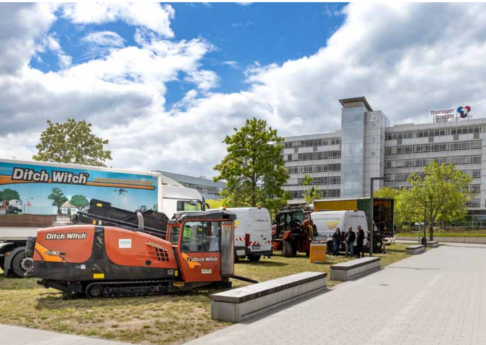
Zum Forum Glasfasertechnologie wurde am 23. Mai 2025 auf dem Gelände der TEAG-Hauptverwaltung in Erfurt modernste Ausbautechnik der Fachfirmen präsentiert.
