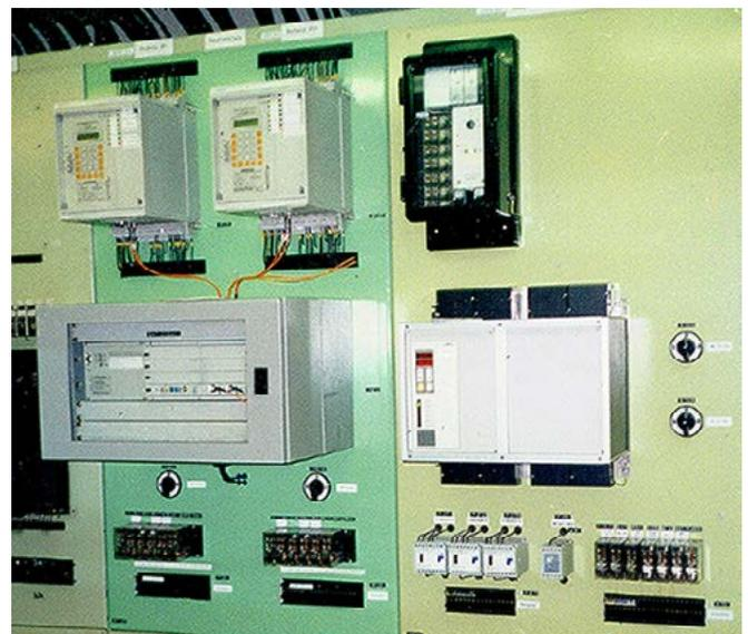
Schutztafeln im UW Remptendorf, 220(380)-kV-Abgang Redwitz 253/254, Hauptschutz Distanzrelais PD551 mit AWE-Zusatz RM1-80, AEG und Reserveschutz Leitungsdiff. 7SD512 mit Signalübertragungsgerät SWT2000D, Siemens
